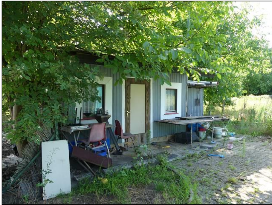
Abb. 11: Gartenhütte im südlichen Teil des Geltungsbereichs, potenzielle Quartierstandorte für Fledermäuse und potenzielle Niststandorte für Vögel (21.07.2020)
